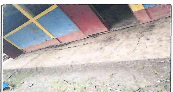
Foto 6: torta del corredor deteriorada.
